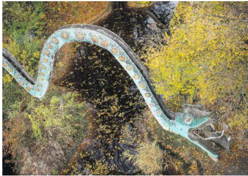
Eine begehbare Schlange, die allerdings gesperrt ist – aus Sicherheitsgründen.
