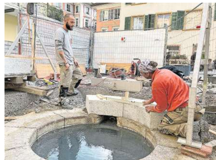
Heisser Stein: Die Quelle wird bedeckt mit einer Platte, die warm wird.
