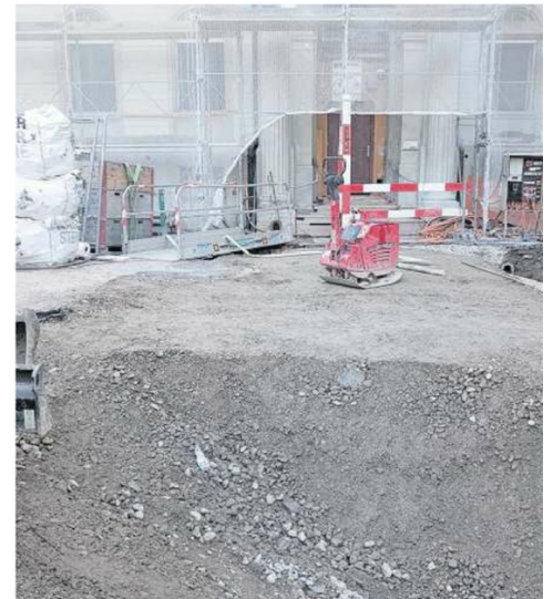
Das Becken beim Verenahof wurde wieder zugeschüttet.
