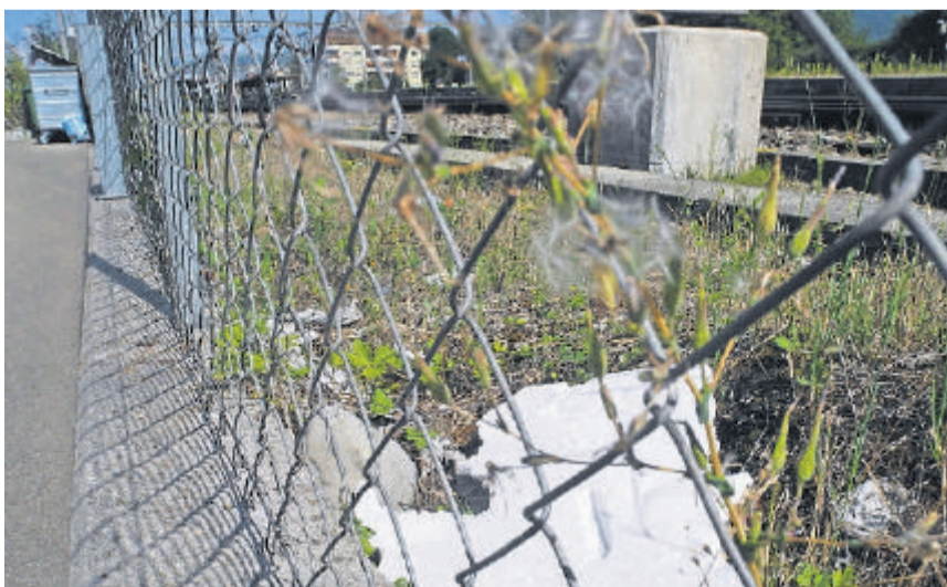
Dort wo Sommerflieder, Heckenrosen und Brombeergestrüpp noch nicht vorge-stossen sind, wird der Müll an den Gleisen besonders augenfällig, GAH
