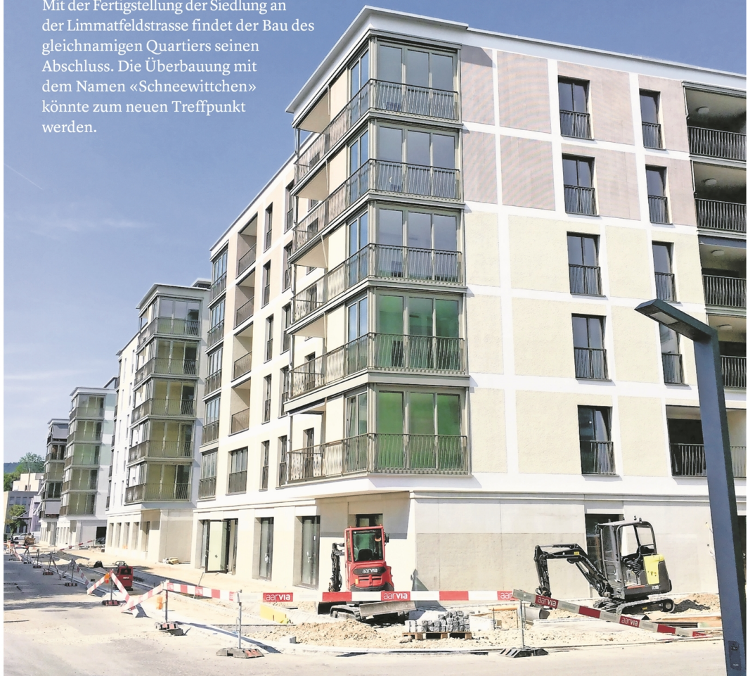
Noch werden Umgebungsarbeiten durchgeführt, doch die ersten Mieter ziehen bereits ein.
