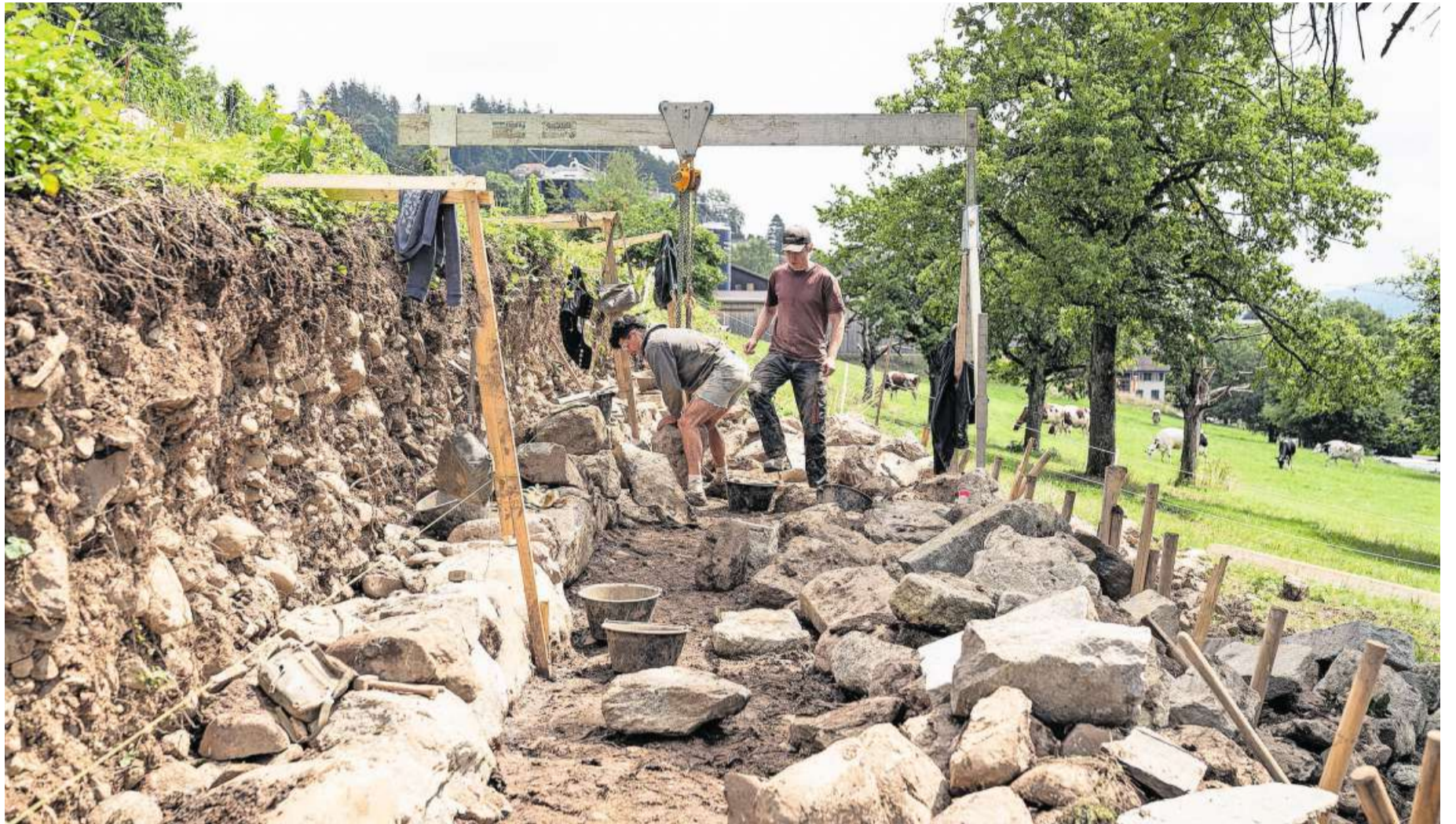
Zivildienstleistende arbeiten in den nächsten fünf Wochen am Wiederaufbau der Trockensteinmauern in Oetwil.
