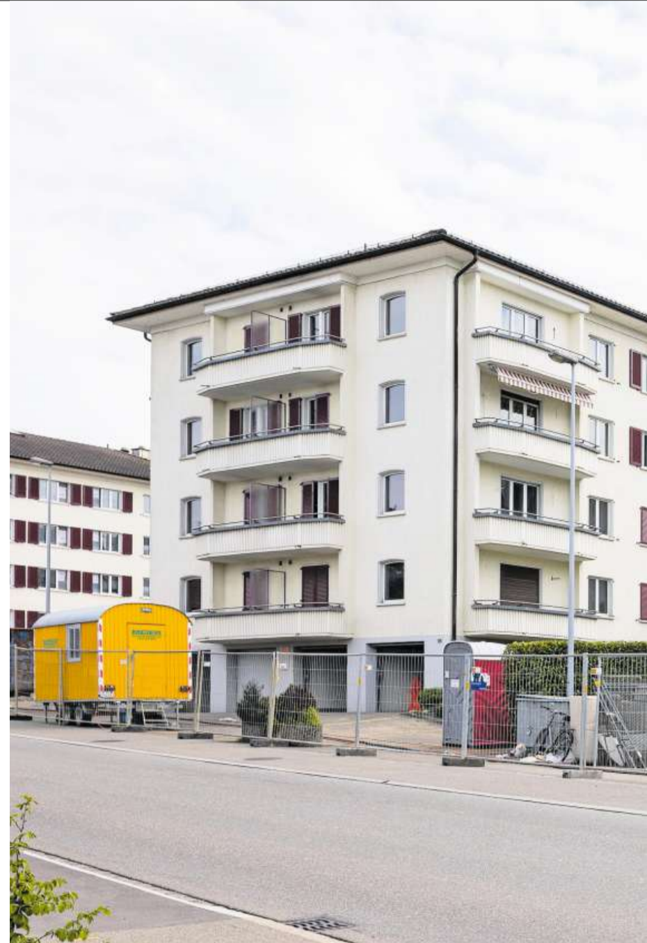
Baustelle an der Windeggstrasse: Die Überbauung Kreuzacker der gemeinnützigen
